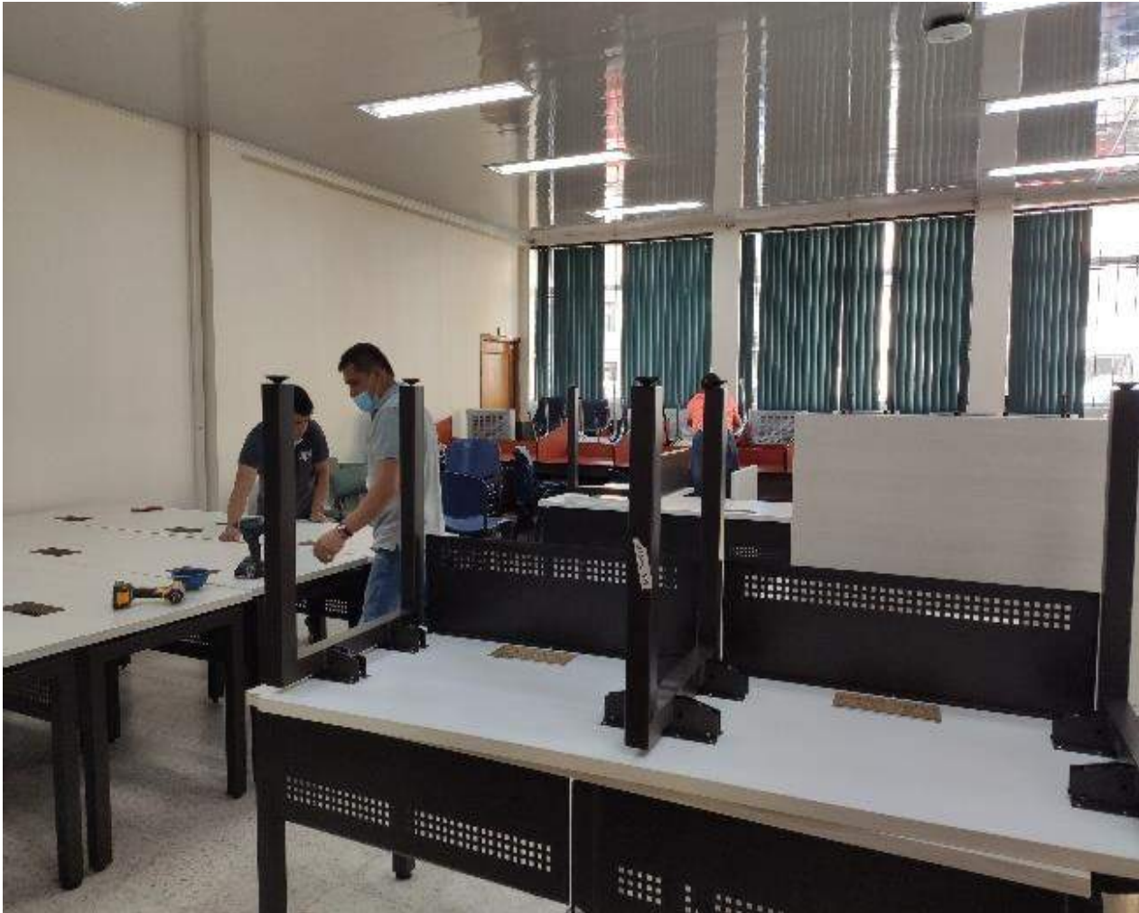
Figura 69. Adecuación Sala de Sistemas
