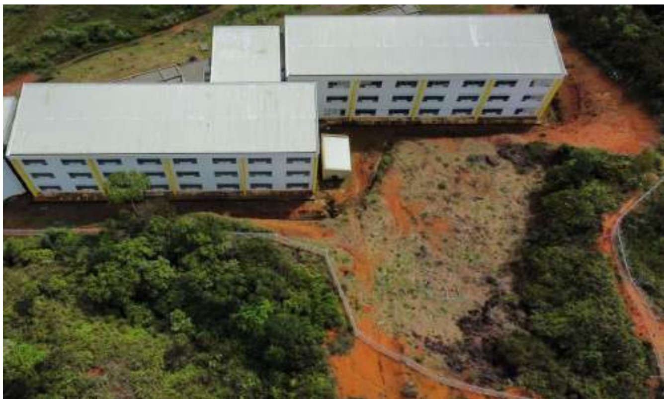
Figura 57. Registro fotográfico desarrollo y construcción de la sede norte de la Universidad del Cauca en Santander de Quilichao
